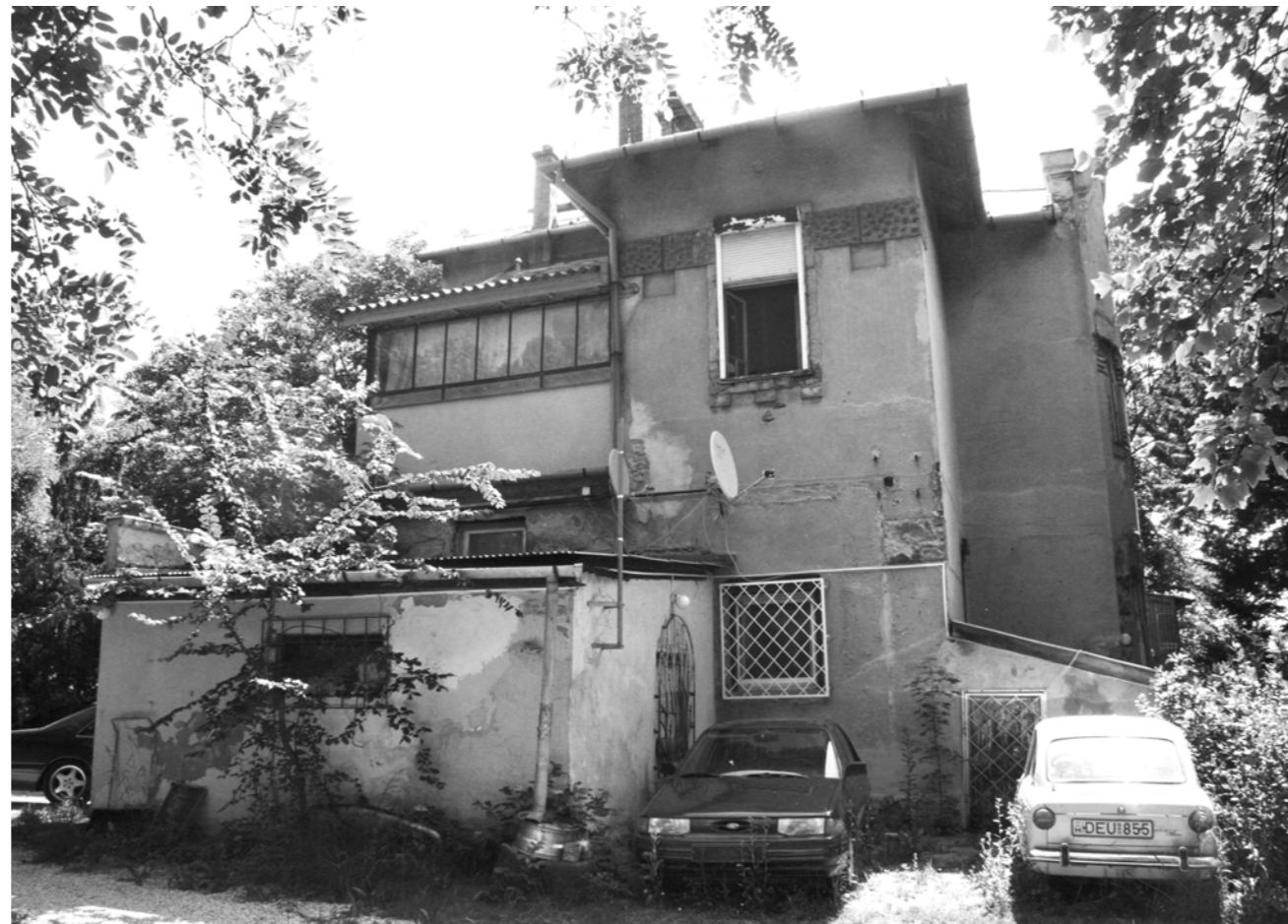
OLDALSÓ HOMLOKZAT: EMELETEN BEÉPÍTÉS, A GARÁZS HOZZÁÉPÍTÉS, A HÁTSÓ RÉSZEN TÁROLÓ UTÓLAGOS TOLDÁSA
