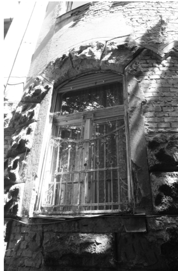
A HÁTSÓ HOMLOKZAT ALSÓ ABLAKA RÁCCSAL
