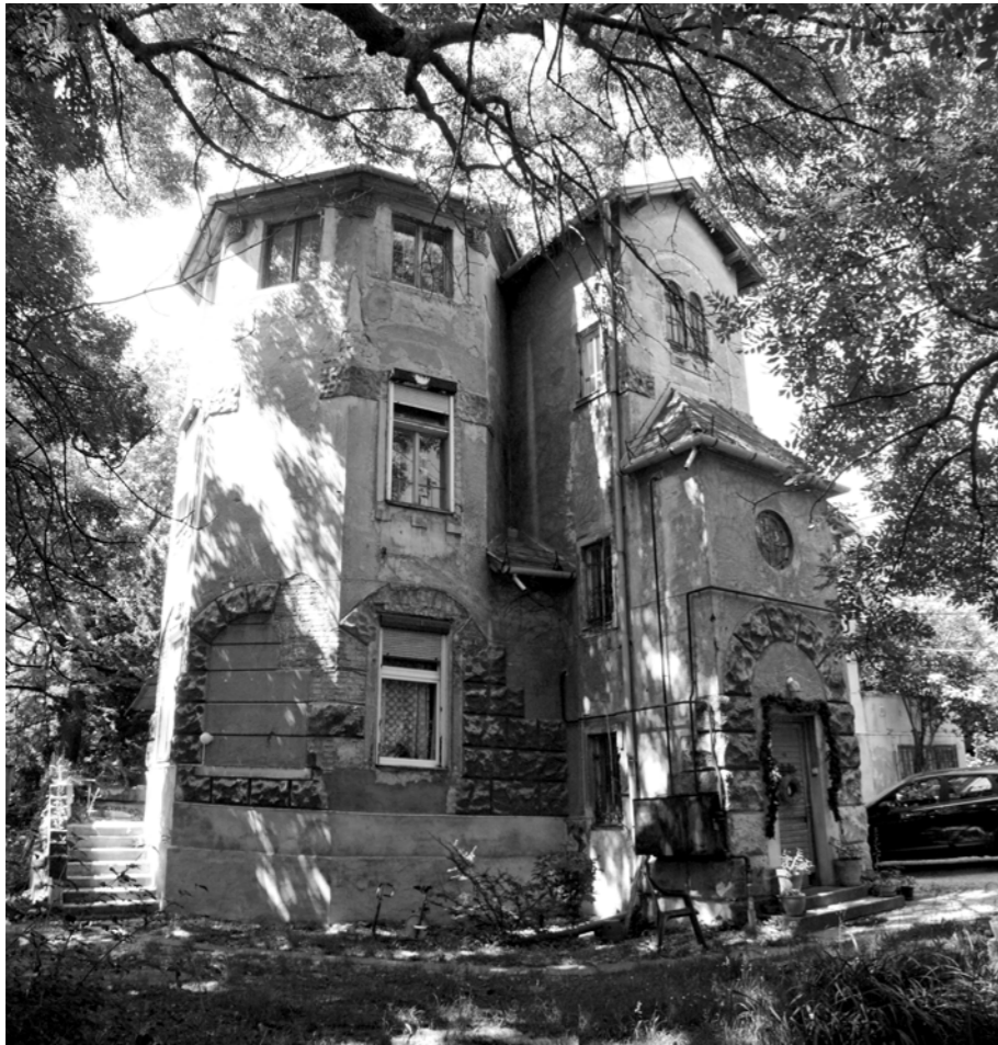
BEJÁRATI HOMLOKZAT A TERASZFELJÁRÓVAL
