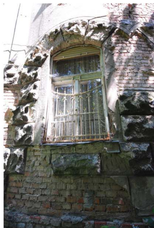
14_a főhomlokzat részlete
