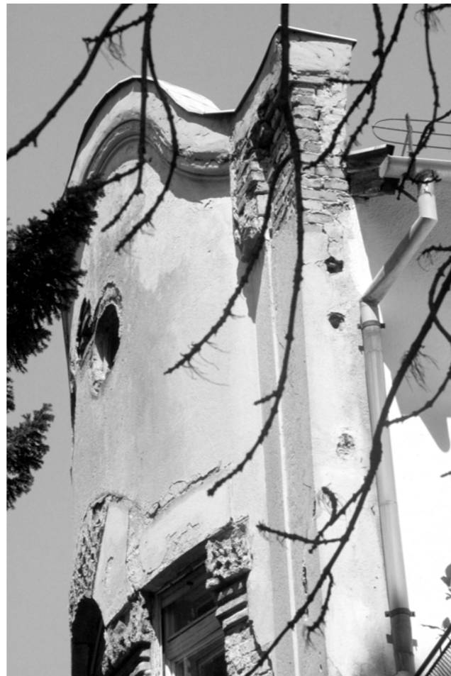
A HÁTSÓ HOMLOKZAT OROMZATA
