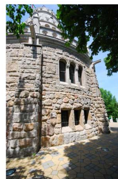
Az alsó két szint homlokzata
