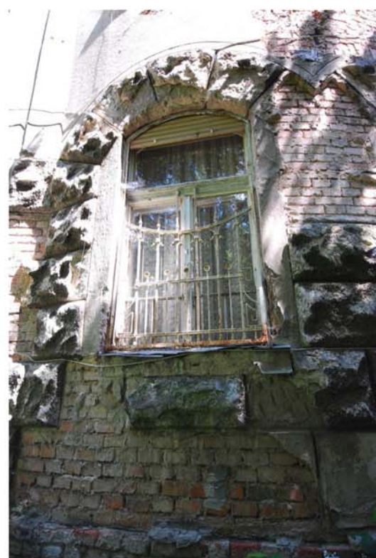
14_a főhomlokzat részlete
