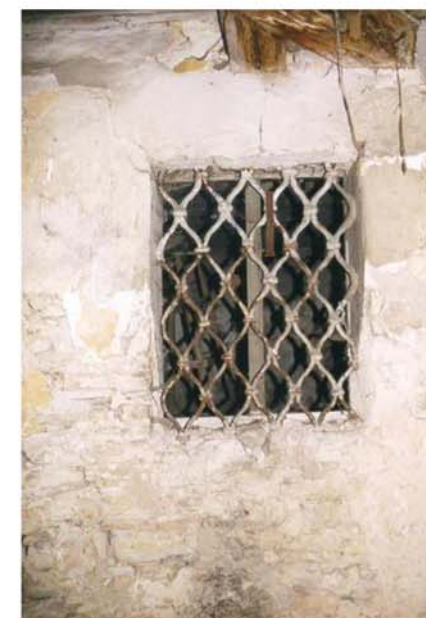
18. Barokk ablakrács a keleti szárnyon
