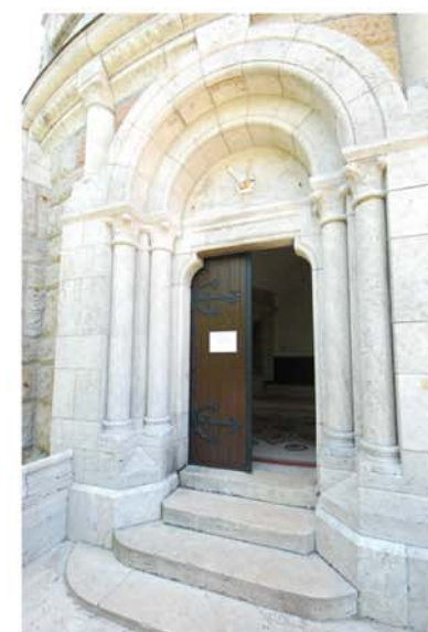
A kilátó bejárata az első emeleten
