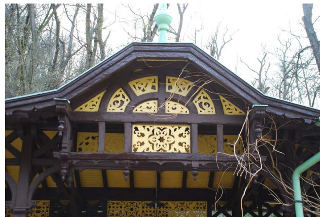
16_az épület 2014-ben
