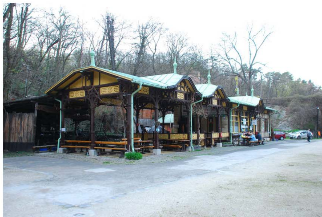
13_az épület 2014-ben
