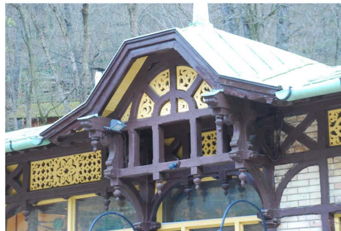
15_az épület 2014-ben
