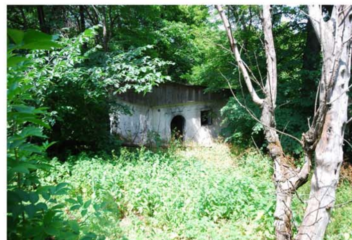
A toronyőri lak leégett melléképülete, 2014
