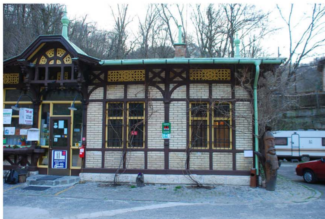
14_az épület 2014-ben
